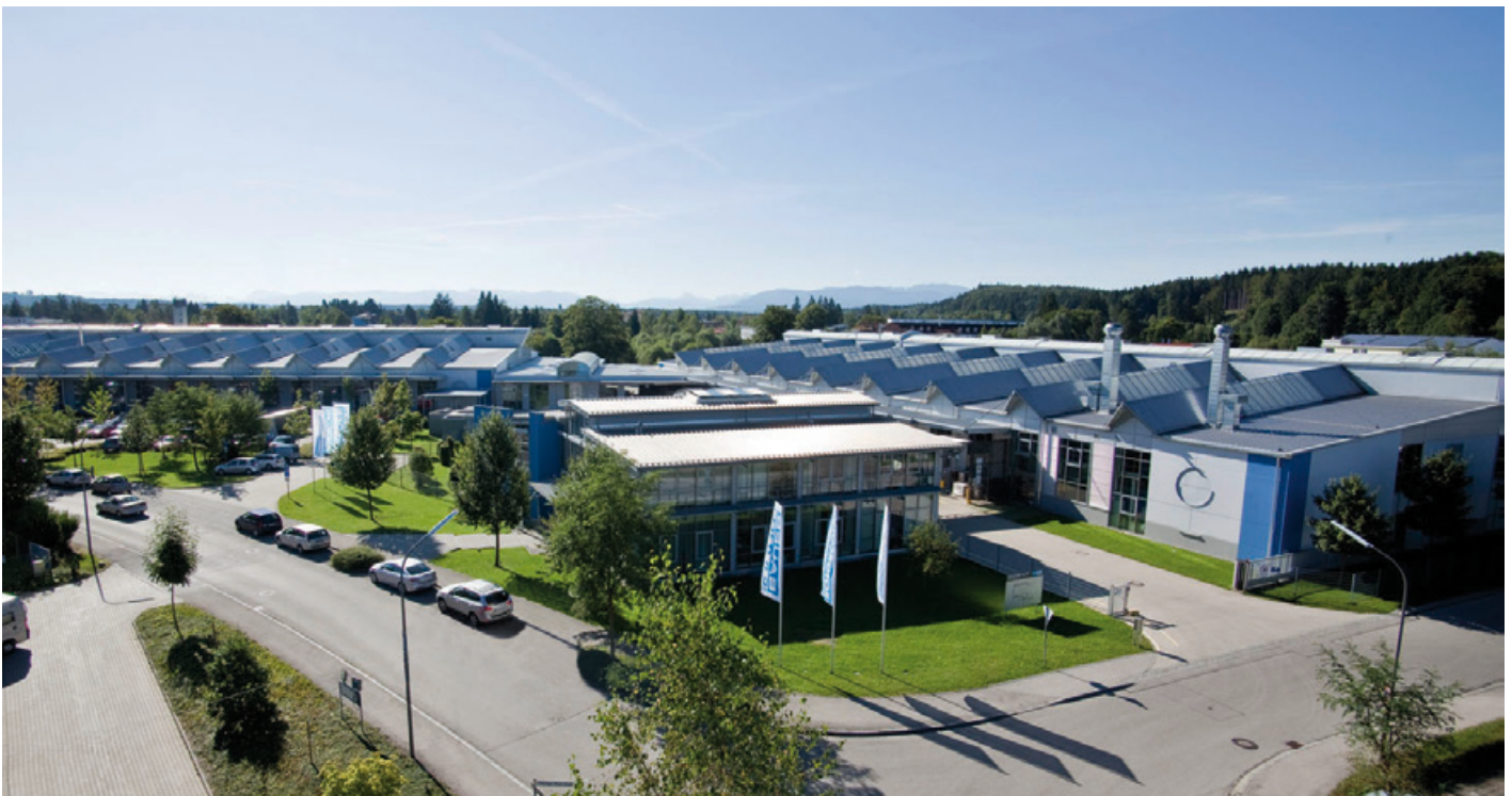
Usine I de BAUER KOMPRESSOREN – Geretsried, Allemagne
