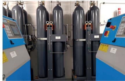
Redundantes Kompressorsystem zur Produktionssicherheit
