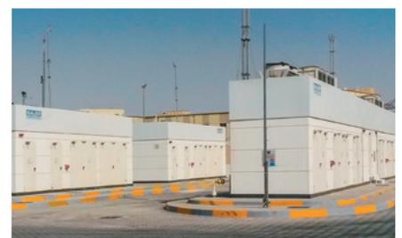
*Geballte Power: Hier wird das Erdgas für den Tankbetrieb verdichtet und gespeichert.*
